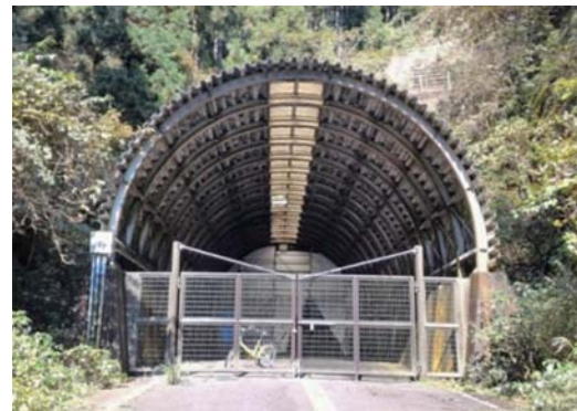
図1 戸ノ口トンネルと閉鎖壁
