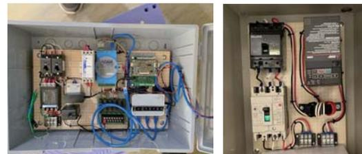
図5 コントローラおよびポンプ制御装置の内部構造
